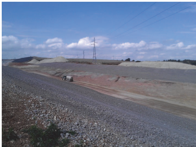
Figure 1. Vue générale du site
