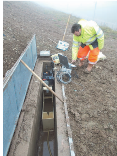
Figure 8. Regard équipé pour la mesure de débits
